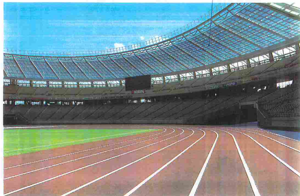
■採光型太陽光発電パネルによるスタンド屋根(味の素スタジアム)
