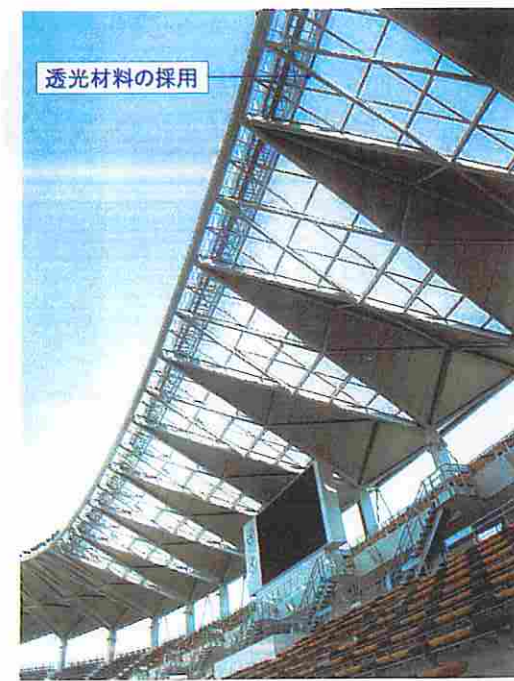
■透光材料(ポリカーボネート板)による日照確保の事例(フクダ電子アリーナ)
