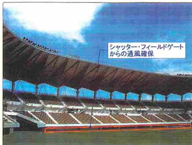
■両サイドスタンド下にシャッターを設置し、風環境をコントロールした事例(フクダ電子アリーナ)
