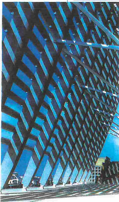
■太陽光発電パネルによる日射遮蔽ルーバー(糸満市庁舎)
